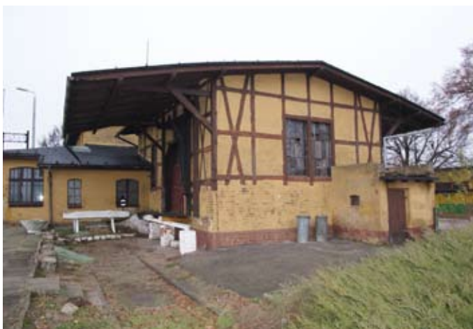
Dworzec kolejowy w Złotnikach przed i po modernizacji
